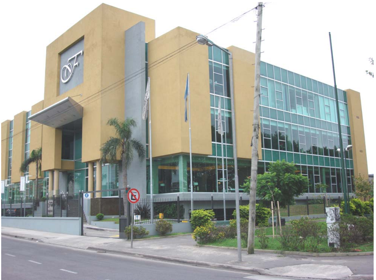
Foto N° 1 – Empresa de Reciclaje Ferre 6950. El presente edificio corresponde a otra empresa
